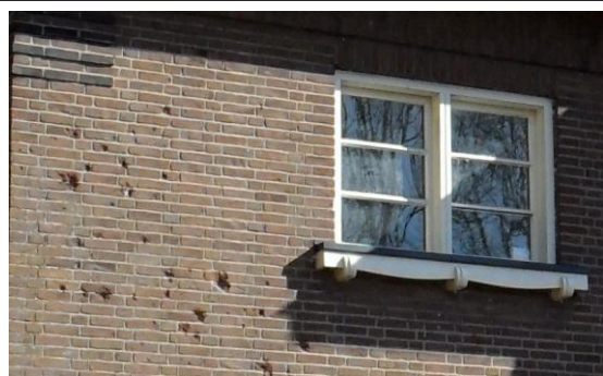
Ramen met horizontale roeden daaronder een fraai gestileerde (bloemen)goot Links beschadigingen door kogelinslagen
